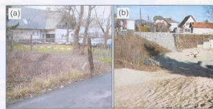
(a) Die alte Sickergrube des Einödbaches an der Ecke Steinriegelgasse/Steinackerstraße. (b) Die neue Sickergrube im Bereich des Kinderspielfeldes an der Sträßgang Straße.
